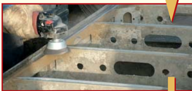
Zsalukeret csiszolása (fémes felület helyreállítása)
