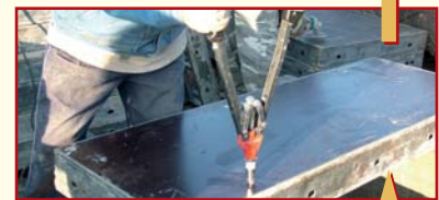
Zsaluhéj rögzítése szegecsekkel
