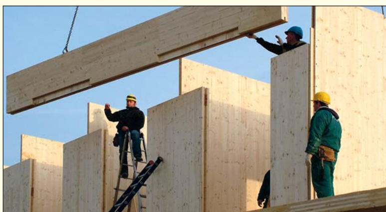
Homlokzati panel beillesztése
